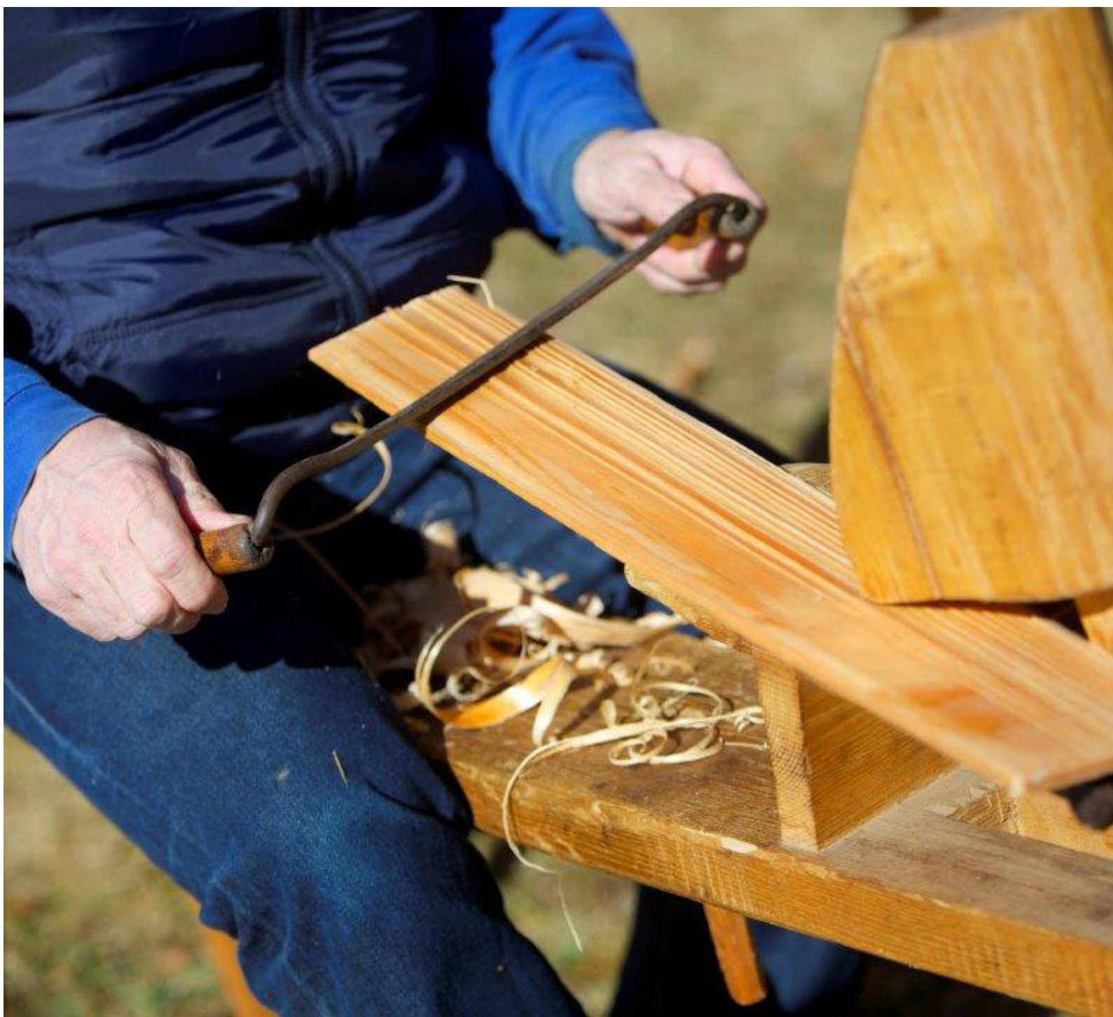
Holzschindelherstellung und -verlegung
